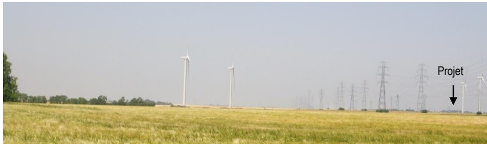
Vue depuis le hameau de St-Martin sur le parc éolien d'Espiers et les lignes à très haute tension
