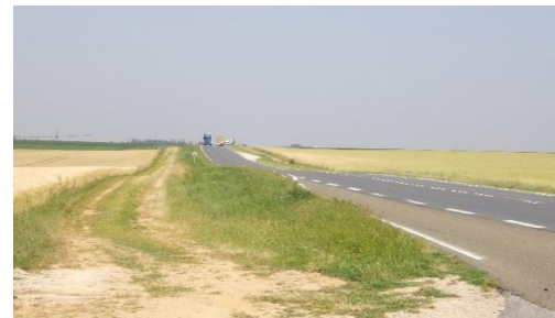
Vue du côté Nord-Ouest de la RN 154 en direction d'Ymonville
