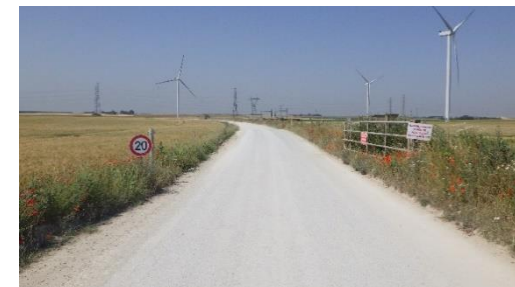
Accès au site aménagée d'une barrière de sécurité et d'un panneau de limitation de vitesse
